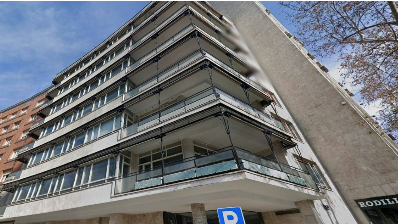
Fachada actual de Castellana 68.
